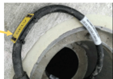
Figure B.4 – Exemple de marquage de terrain (feux encastrés)
